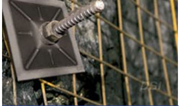
♦ Anclaje en roca
