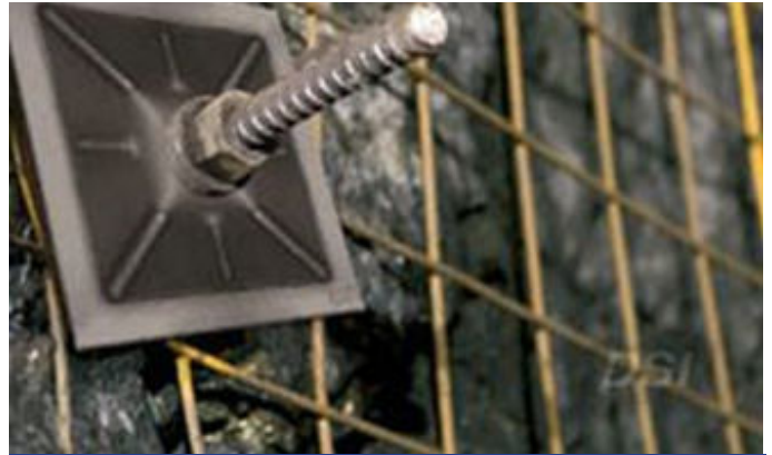
♦ Anclaje en roca
