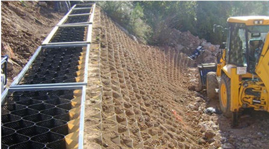
◊ Controlan la erosión en los taludes.
