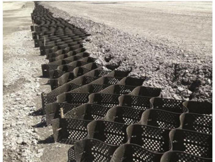
Este material se ha diseñado para aminorar los efectos negativos de la erosión del agua y el viento superficial sobretodo aplicado a terraplenes y taludes. Permiten la hidrosiembra.
