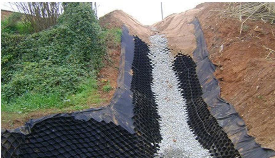
• El sistema ofrece una efectiva protección de cobertura para geomembranas.
